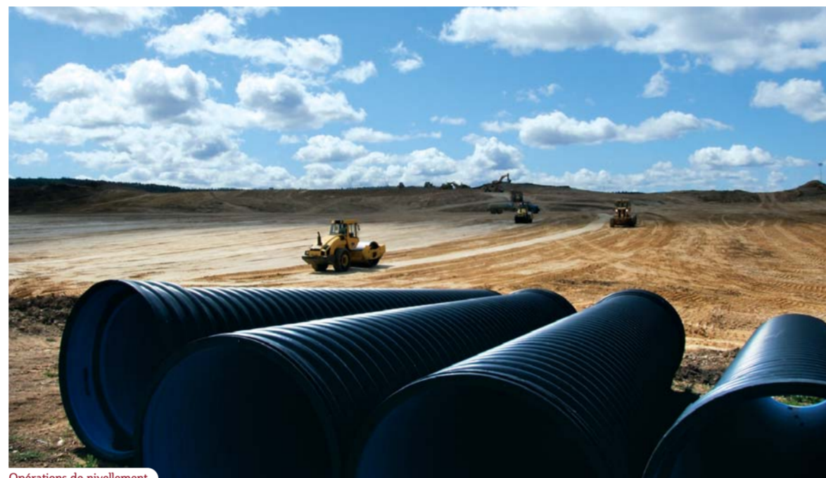
Opérations de nivellement
